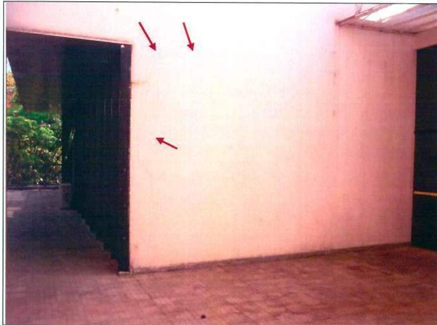
**Foto 03:** fissuras presentes nas portas e janelas devido a redução de seção causando o enfraquecimento localizado das paredes.
