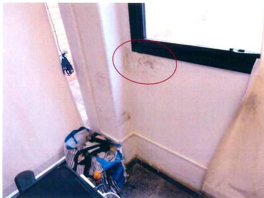
Foto 06: vestígios de infiltrações devido à fissuras localizadas próxima às janelas.
