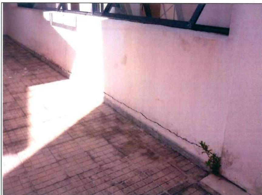
Foto 02: Detalhe de trinca entre a edificação e laje de piso, indício de movimentações da estrutura.
