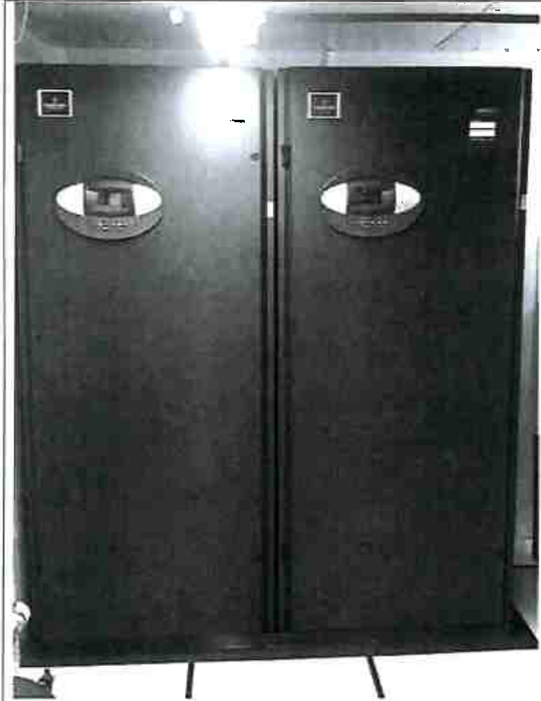
Figura 13 - Sistema ininterrupto de energia – UPS
