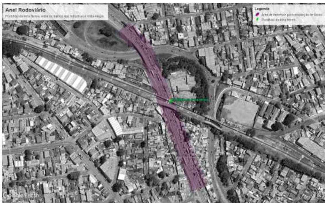
Fig. 01: Foto aérea do pontilhão da linha férrea no Anel Rodoviário, entre os bairros das Indústrias e Vista Alegre. Fonte: Google Earth , alterada pelo autor.
