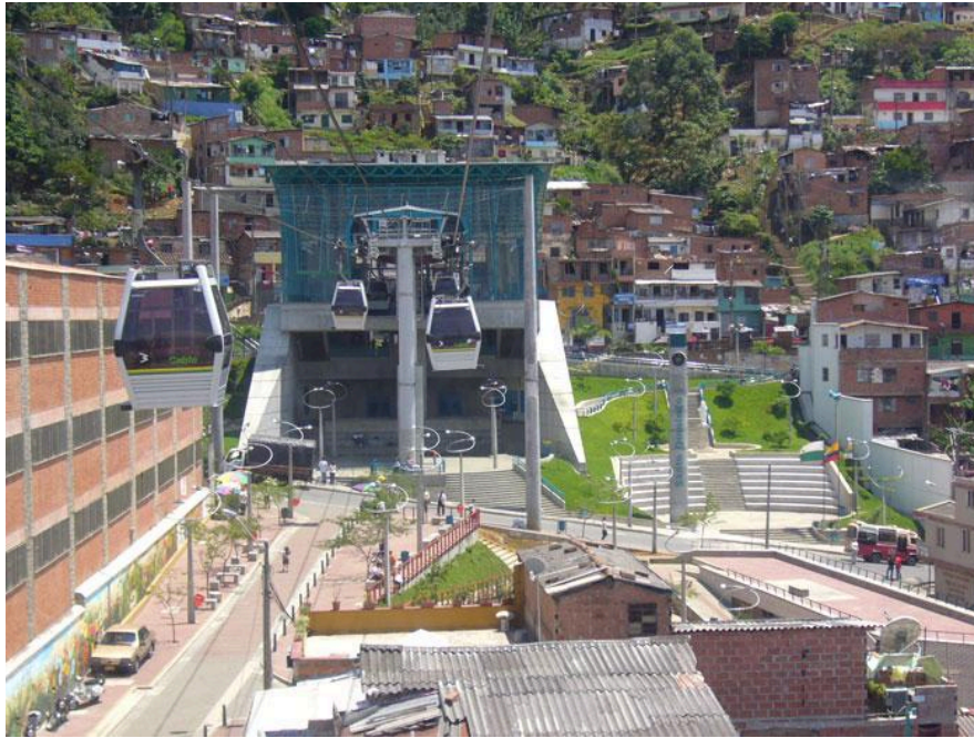
Figura 2: As cabines do teleférico Metrocable em operação
