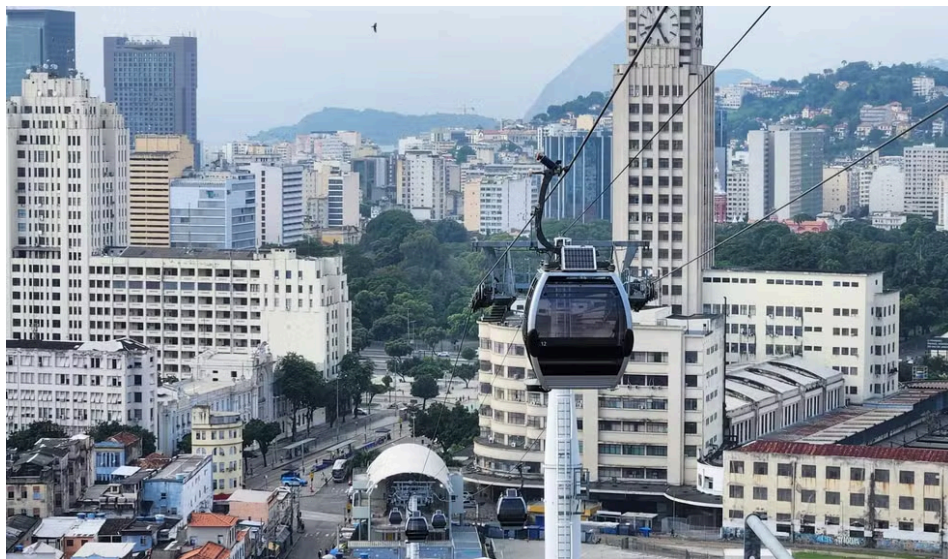
Figura 8: Teleférico da Providência
