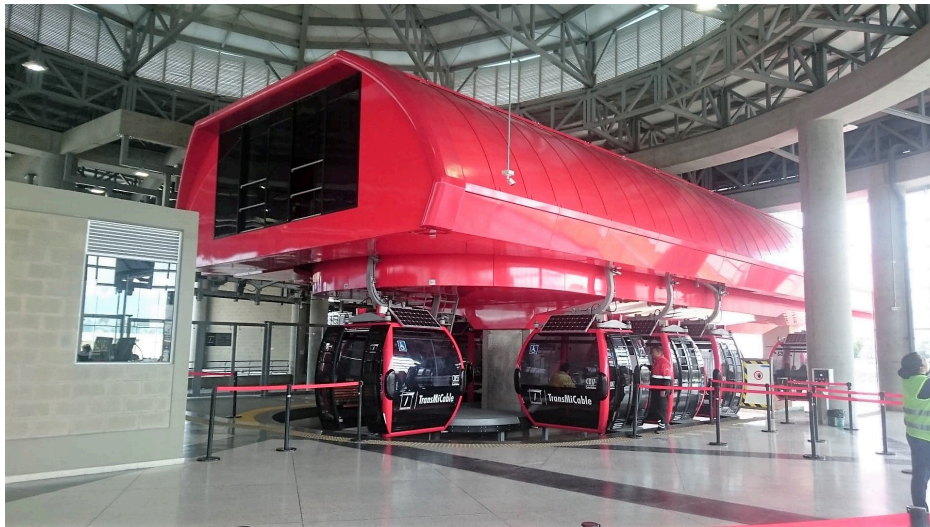
Figura 6: Estação Tunal da Linha T do sistema TransMiCable em Bogotá
