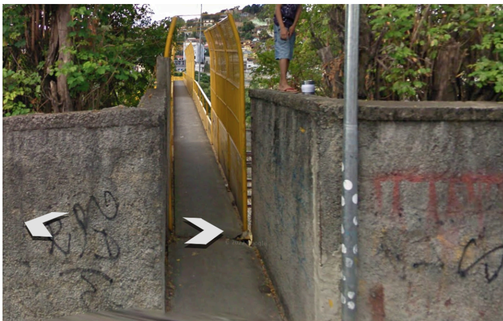
Entrada da passarela na rua Conselheiro Rocha em julho de 2009
